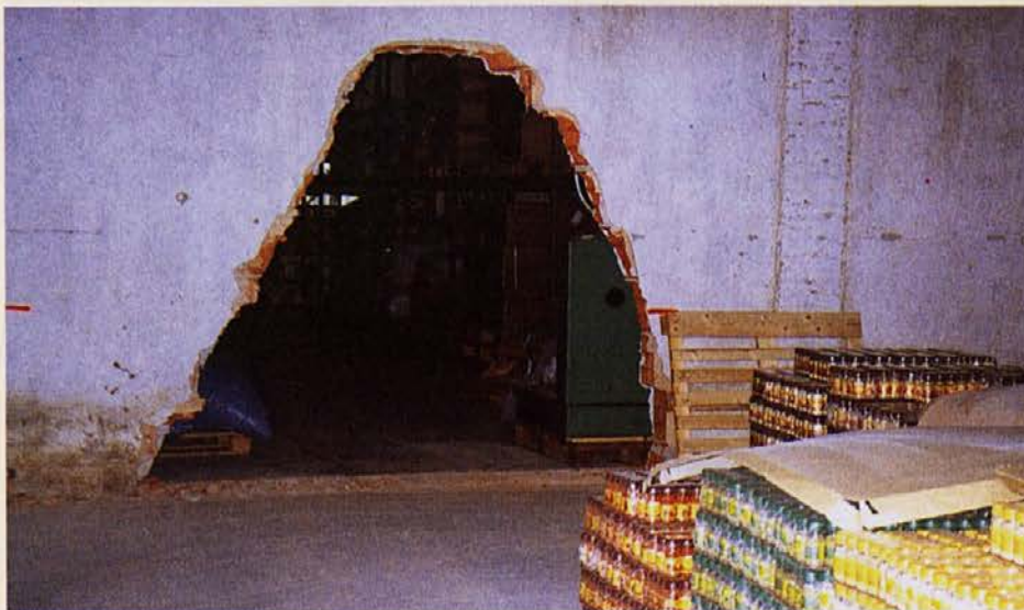
Zasilni vhod v pakirnico začimb med obnavljanjem tlakov
