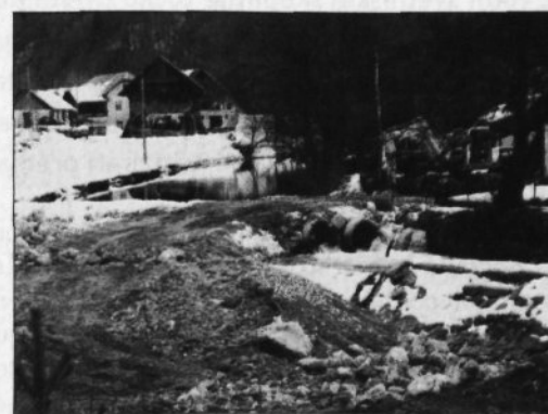
Gradbišče ribje steze na reki Mirni
