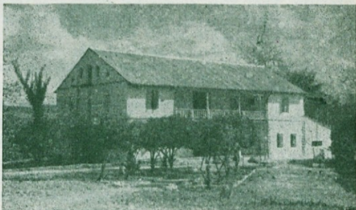
Misijonska hiša v Katondwe. Zgrajena je bila l. 1914.
