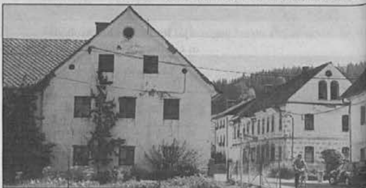
Stare Žiri so res potrebne temeljite obnove
