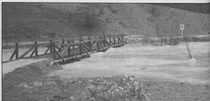
Računamo, da bomo letos za obnovo mostu pripravili dokumentacijo
