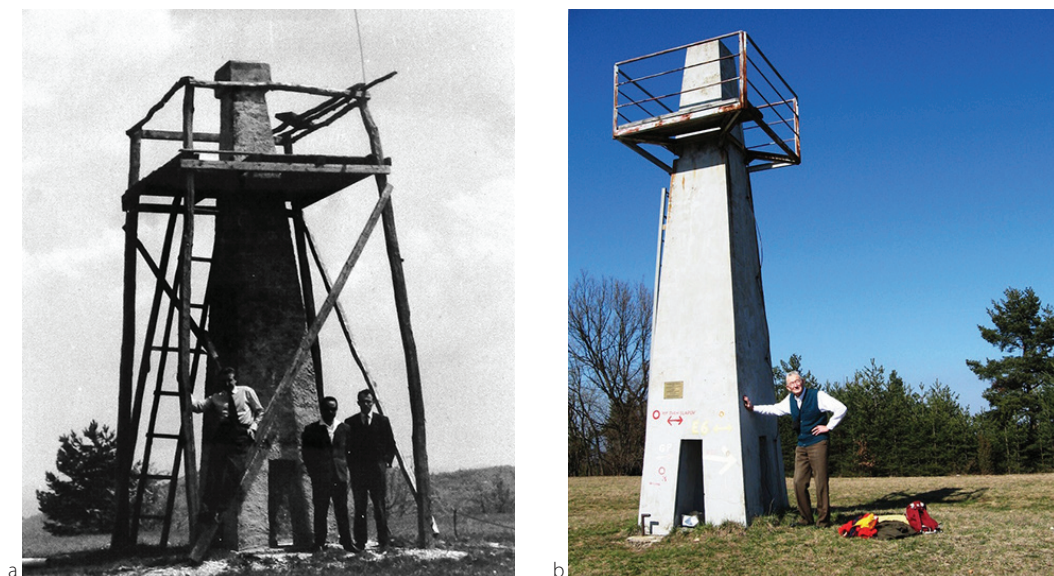
Slika 10: Opečnat steber I. reda 173 Kucelj: a) stanje leta 1964 z originalnim lesenim merilnim odrom in b) leta 2010 s kovinsko lestvijo in železnim montažnim odrom (foto: M. Jenko).
