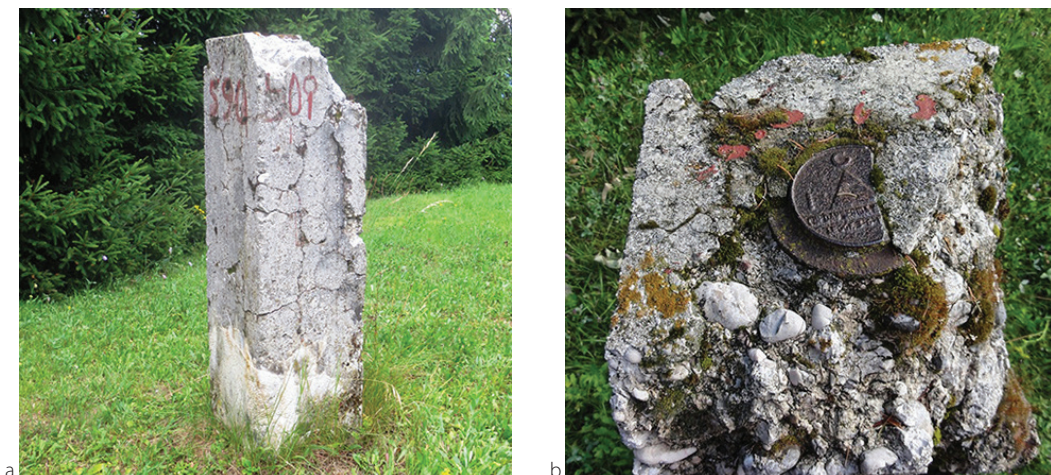
Slika 8: Toško Čelo, točka mreže II. reda 365 Ljubljana: a) stanje stebra v letu 2014 (foto: M. Jenko), b) detajl iz 2020 (foto: S. Tršan).
