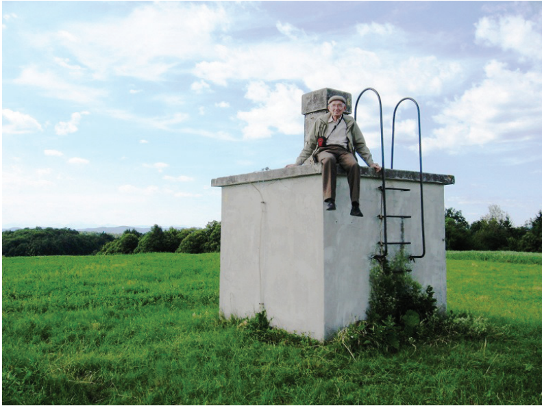
Slika 11: Steber na visokem zidanem podstavku točke I. reda 396 Zglavnica (foto: M. Jenko, 2010).
