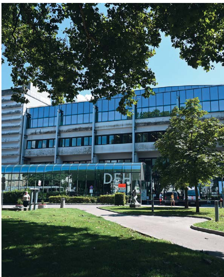
Ena od novosti bo nadzidava stavbe H.
