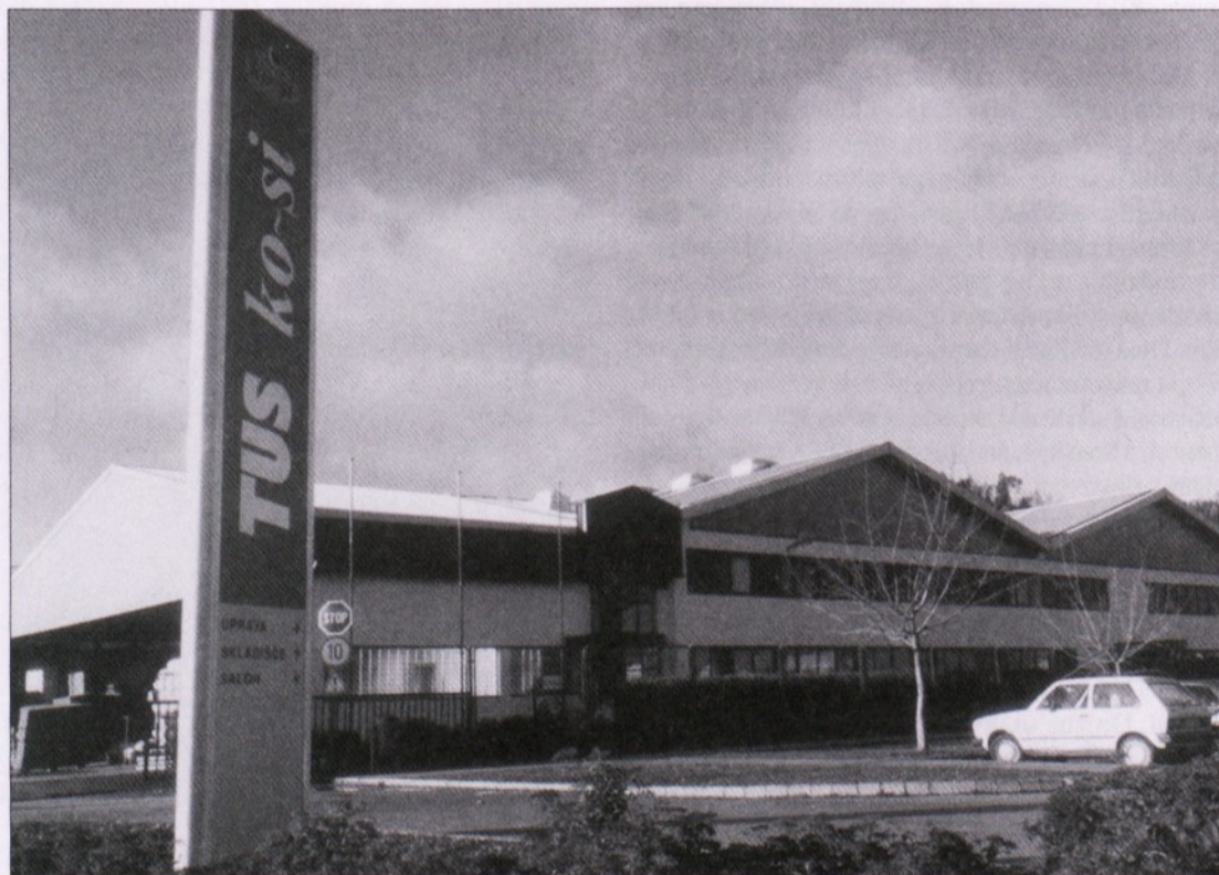
Poslovna stavba podjetja TUS KO-SI v Slovenj Gradcu
