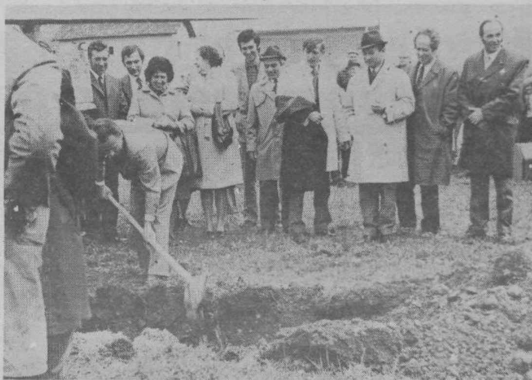
Predsednik gradbenega odbora Tone Matjažič je simbolično položil temeljni kamen za novo šolo v Zalogu
