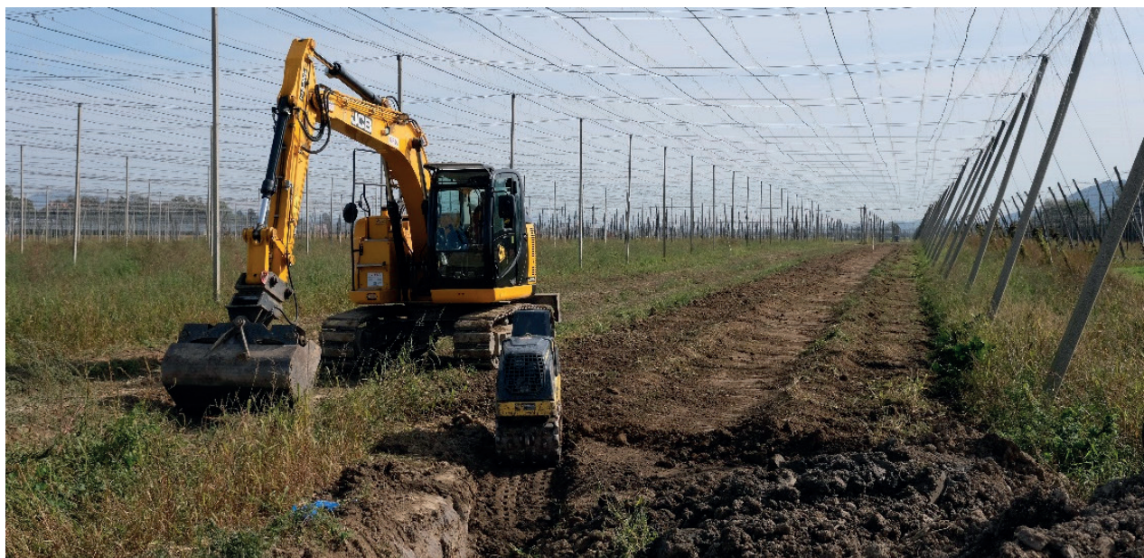
Utrjevanje zemljine nad zasipanimi primarnimi namakalnimi cevmi na namakalnem sistemu Novo Celje (Foto: I. Rihtar)
