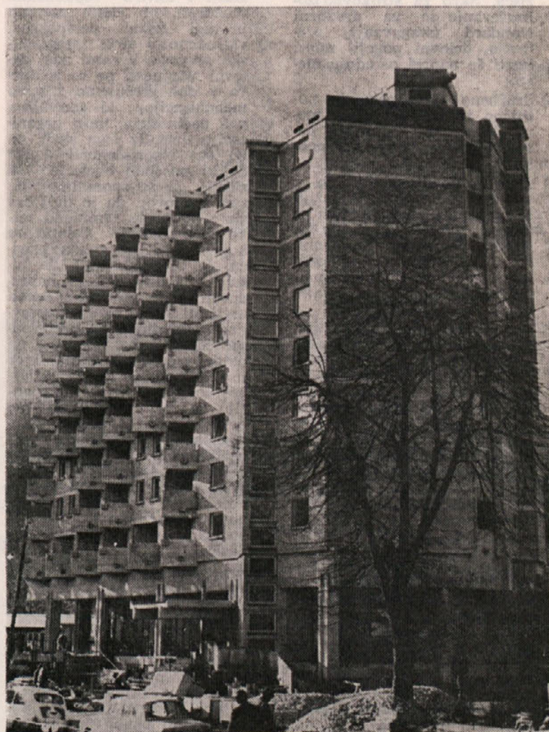
Dom upokojevcv tik pred otvoritvijo. Zahteven objekt iz vidnega betona in naravne opeke je bil v roku dograjen
