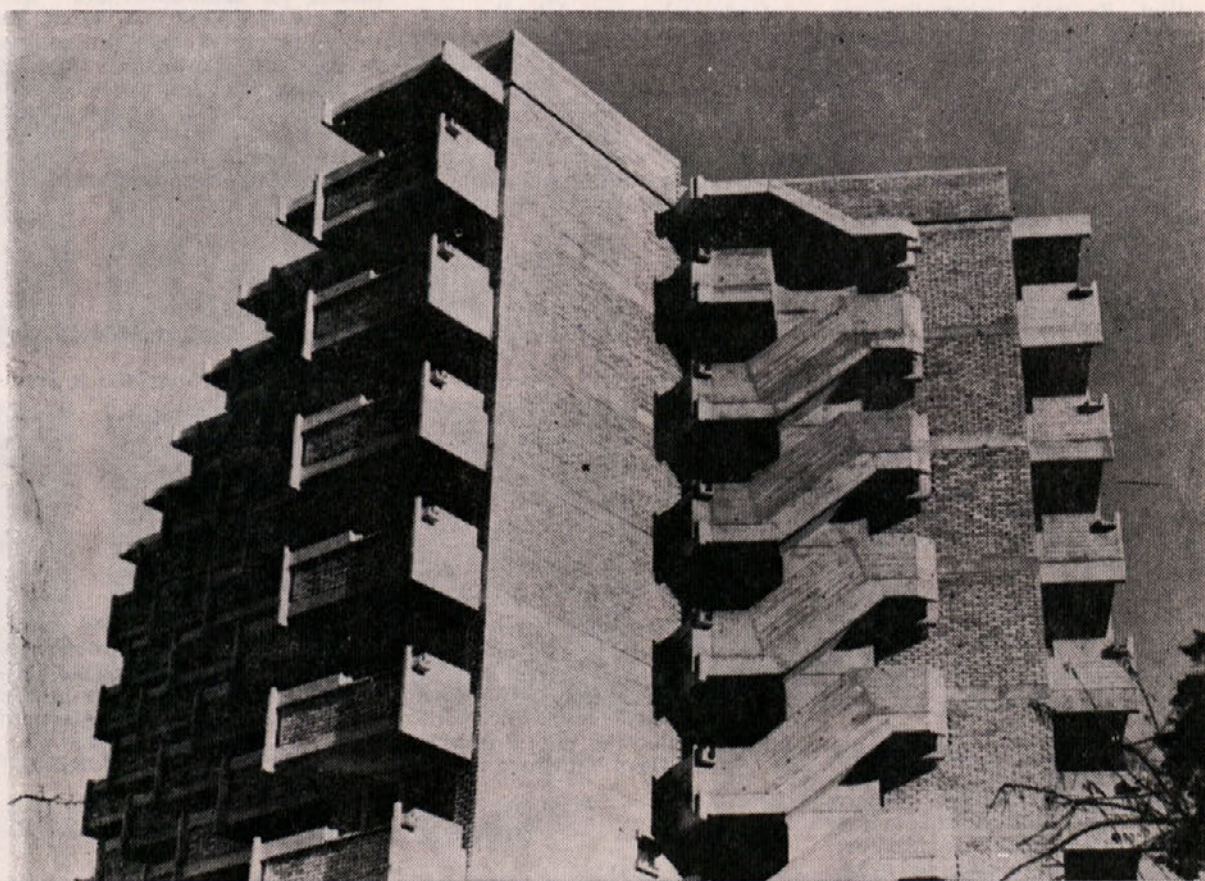
Detajl južne fasade — doma upokojencev — z varnostnimi stopnicami.
