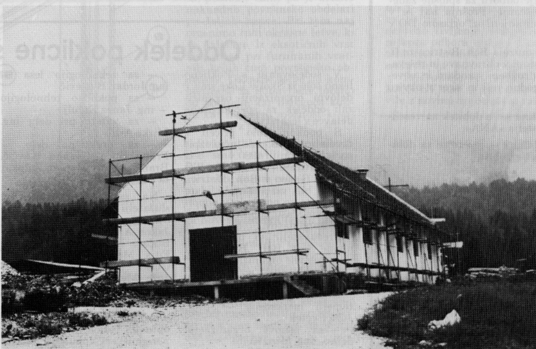
Adaptacija skladišča vnetljivih snovi v TO Tomaž Godec (foto M. Korošec)
