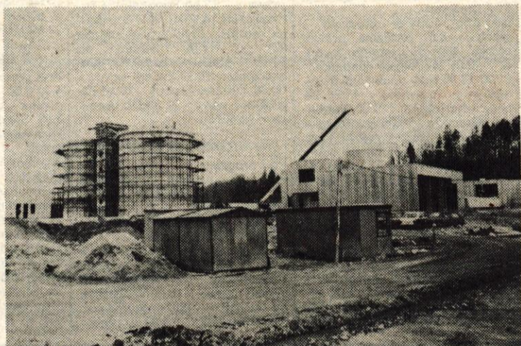
Bazeni za mehansko in biološko čiščenje so že zgrajeni
