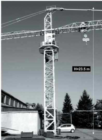
Fig. 1. Tower crane POTAIN 744e
