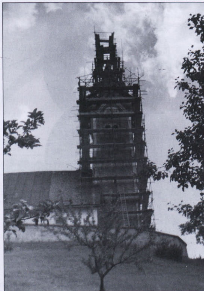
Odranje za obnovo ostrešja in fasade 13.8.1996.
