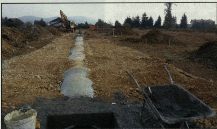
Pri urejanju komunalne infrastrukture
