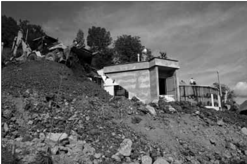
Gradnja nadomestnega vodohrana za naselje Žiri nad Tabrom
