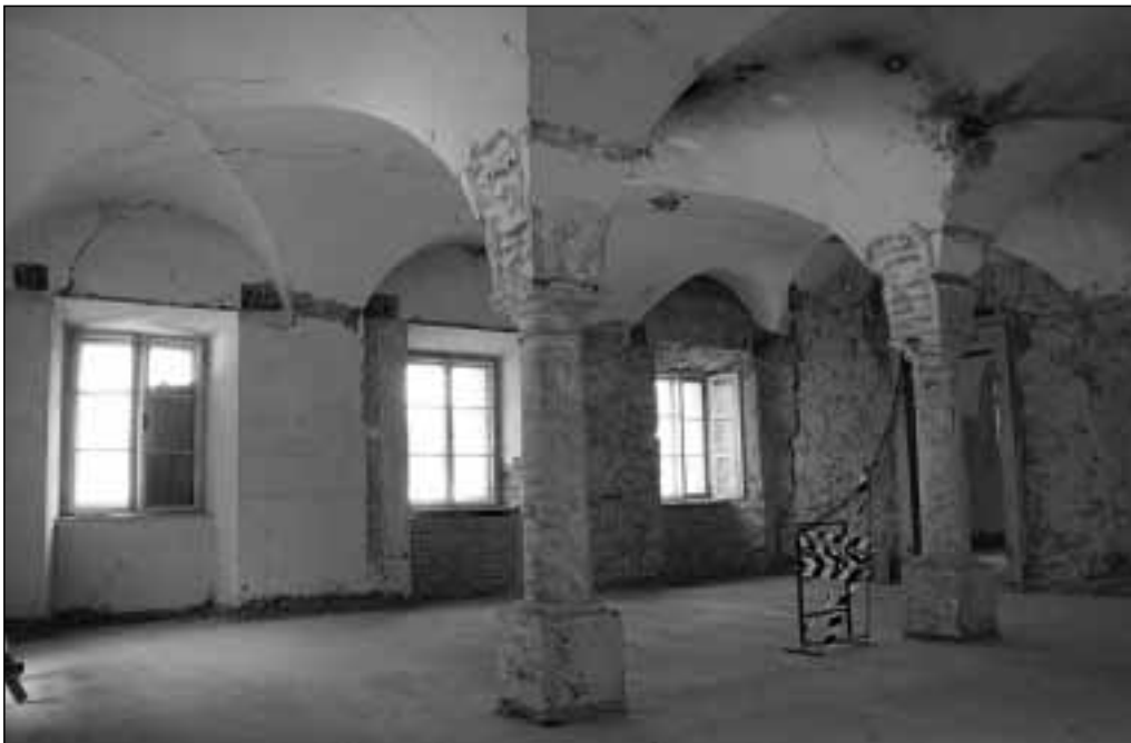
Obnovitvena dela v Stari šoli so pokazala doslej skrite lepote zgradbe
