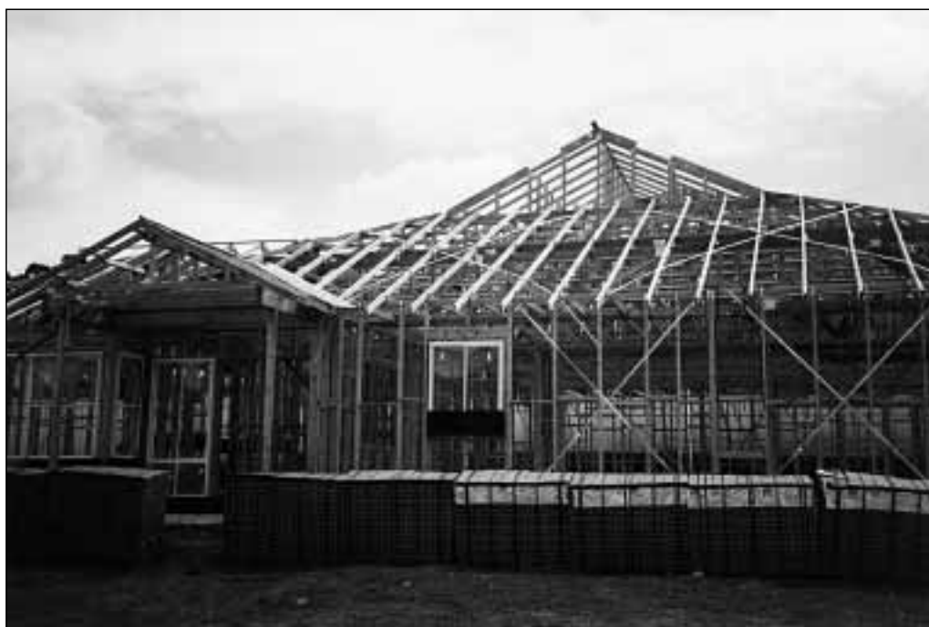
Takole v Avstraliji nastajajo nove hiše; leseno ogrodje, spredaj zložena opeka, s katero bodo obložili zgradbo v Narellenu
