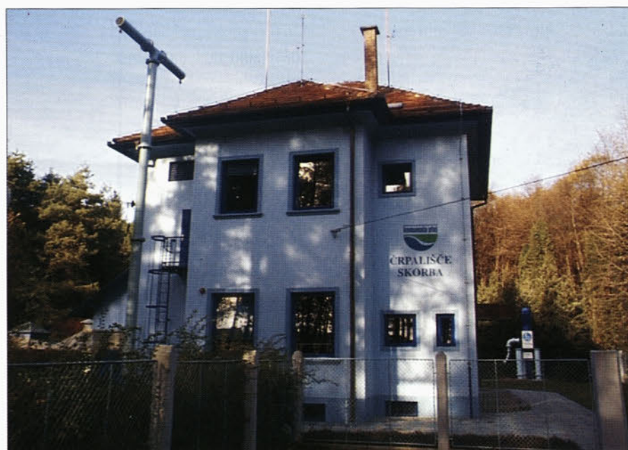
Nadzorni center vodooskrbnega sistema Ptuj
