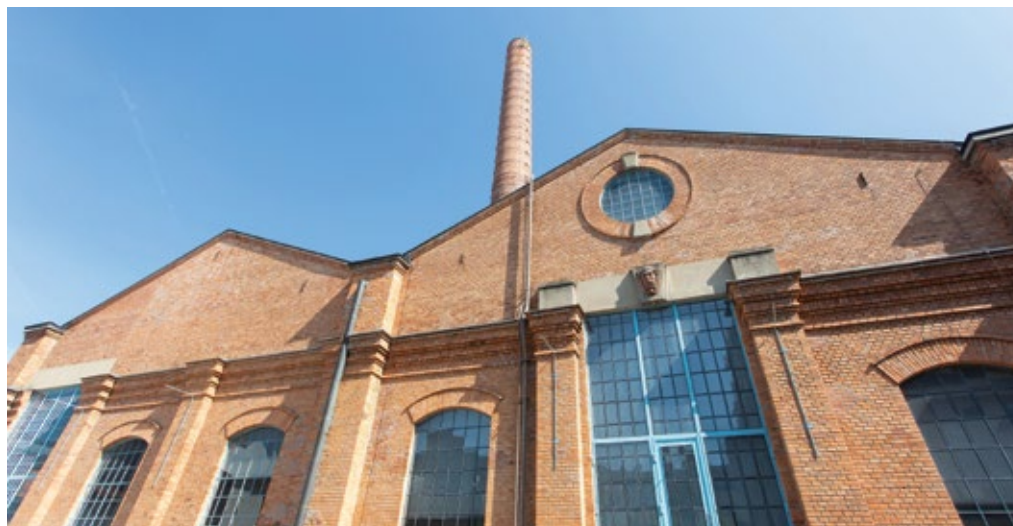
Stara mestna elektrarna – Elektro Ljubljana (SMEEL). Foto: Nada Žgank. Bunker.
