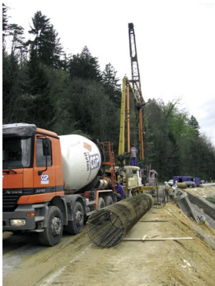
Slika 3 • Betoniranje pilotov pilotne stene PZ-1
