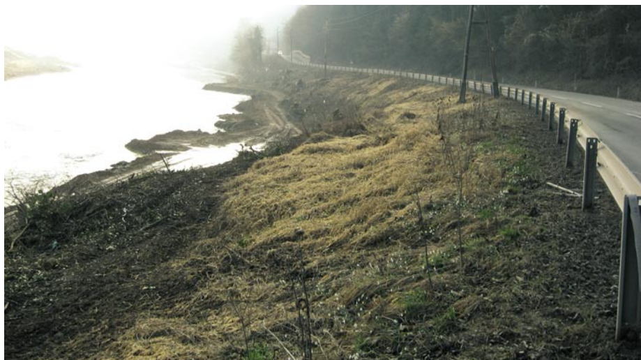
Slika 1 • Odsek gradnje pilotne stene PZ-1 in PS-1
