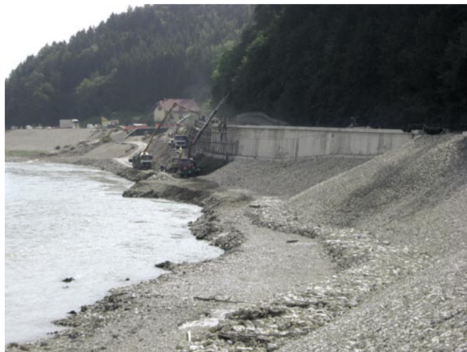
Slika 7 • Izvedba pilotne stene PS-1
