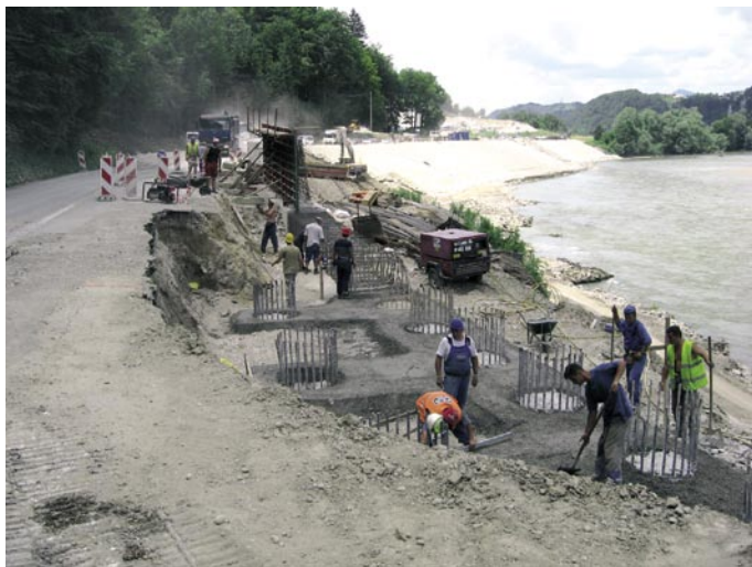
Slika 6 • Izvedba okvirne podporne konstrukcije
