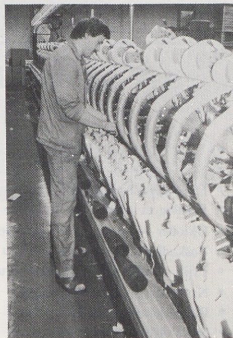
SUKALNICA: Odstranjevanje tekočih napak na previjalnih glavah.
