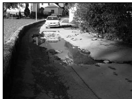
Sila vode je prestavila asfaltno prevleko.
