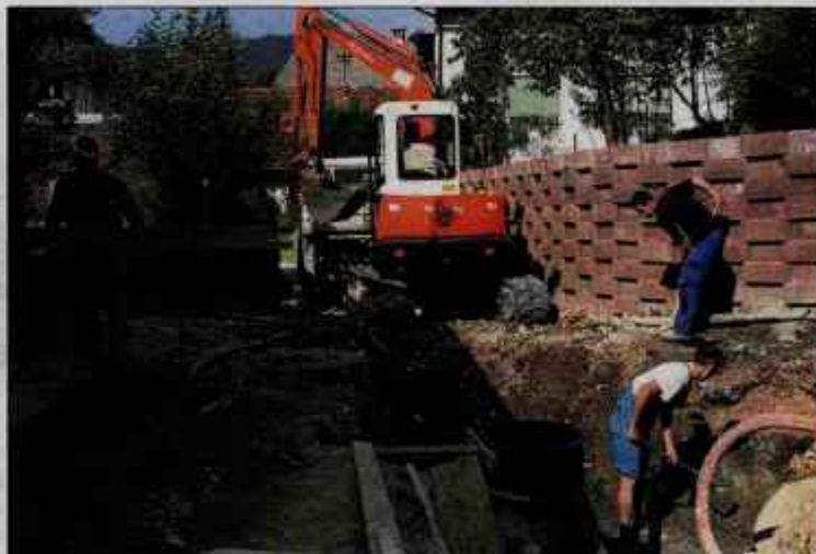
Trenutno gradijo kanalizacijo pod Vogvarjevo hišo v Spodnjih Dupljah.
