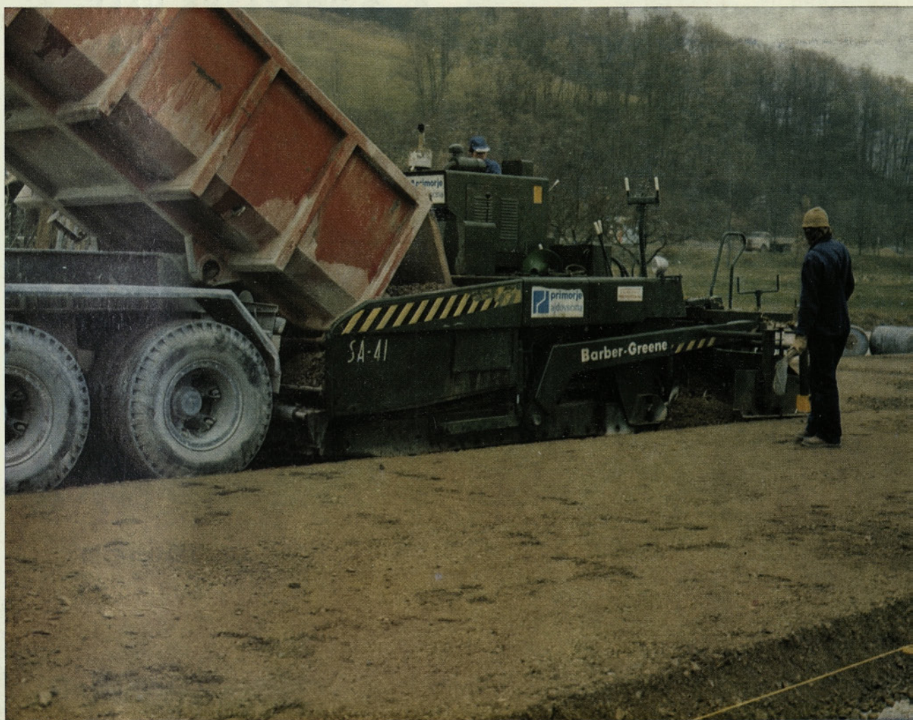
SGP PRIMORJE AJDOVŠČINA: Polaganje cementne stabilizacije na odseku AC Dolgi most—Vrhnika
