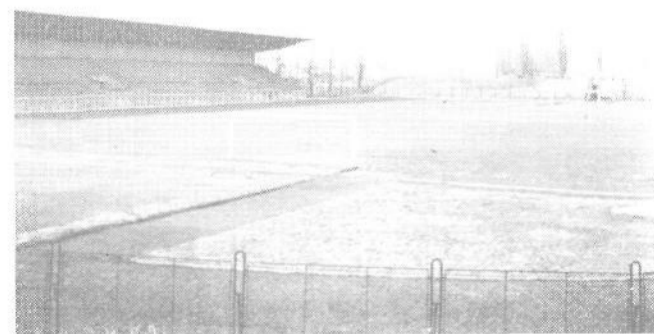
Stadion SD Ljubljana je zaradi vedno večjih okvar vedno manj izkoriščen. Treba je ugotoviti, kdo je njegov pravni lastnik in začeti s sanacijo.
