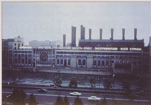
Električna centrala na nasprotnem bregu kanala.
