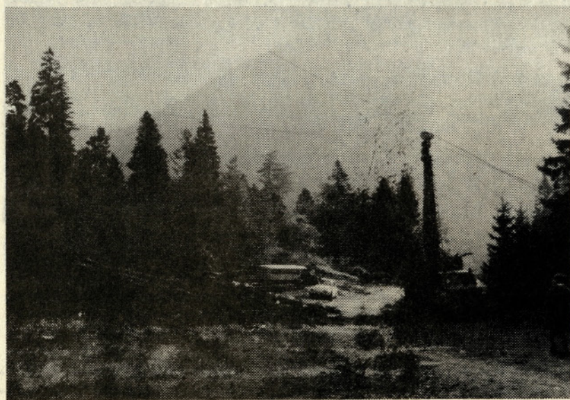
Montaža Urusa za spravilo po strmini navzdol.
