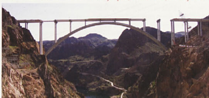
zaključna dela na novi povezavi med Arizono in Nevado
