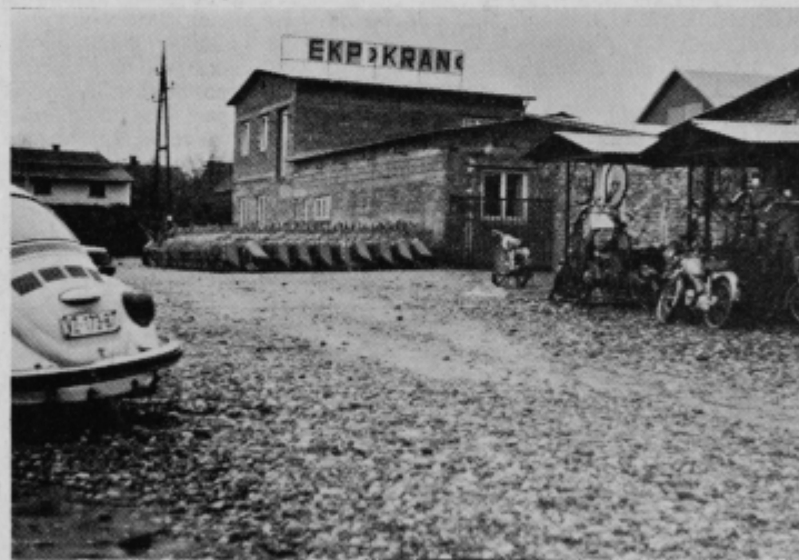
Upravno poslopje ormoškega KRANA
