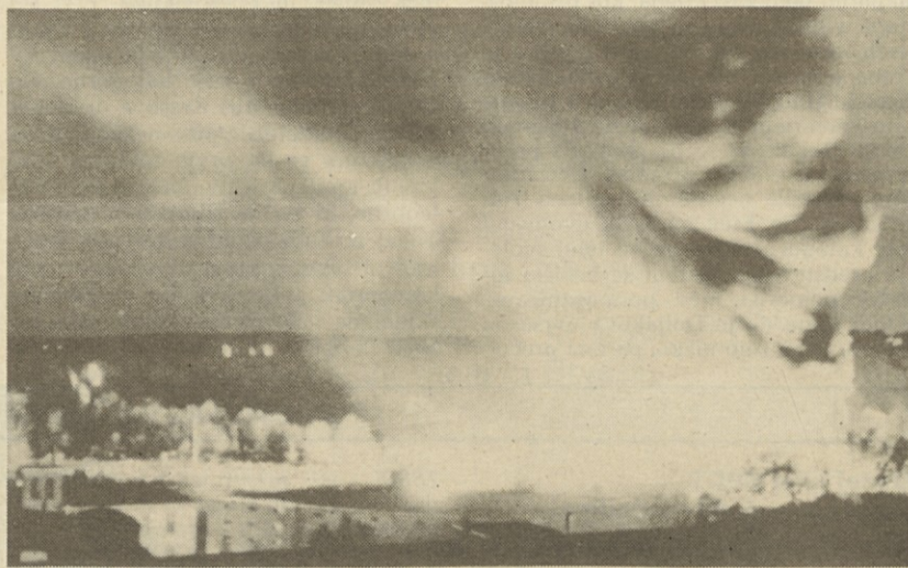
Hrabrnosti in prisebnosti nekega delavca, ki je zaprl ventile rezervoarjev, se morajo zahvaliti, da ni požar v petrokemičnem obratu na Rhode Islandu povzročil še večje škode Telefoto AP
