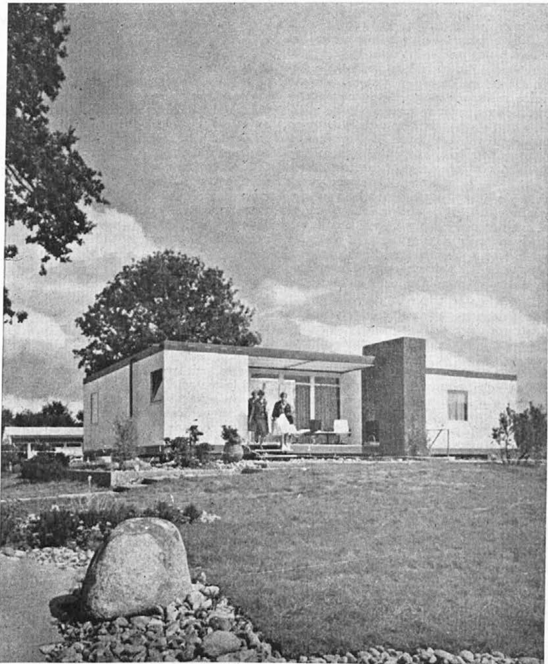
Nam že znano podjetje Hoesch, v katerem je vključena tudi železarna Westfalenhütte v Dortmundu, je po daljšem razvoju začelo izdelovati železne individualne hišice. Večinski gradbeni material je torej iz njihovega specialnega proizvoda »platal« (jeklena pločevina, vezana z umetno maso). V tovarniškem listu, kjer o tem več poročajo, ni konca ne kraja lepim slik ter utemeljitve zadovoljstva bivanja v teh zgradbah
