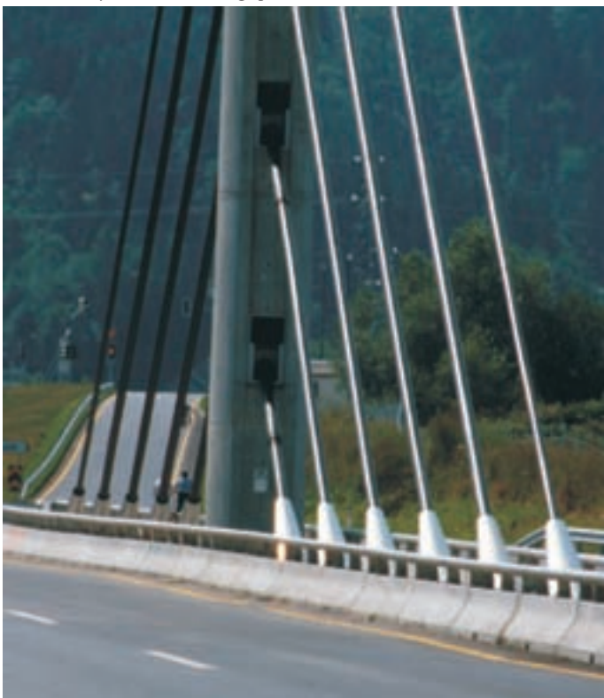
Slika 5: Vsi konstrukcijski detajli so oblikovani enostavno in preišljeno. (foto Miran Kambič) The design of construction details is simple and rational.
