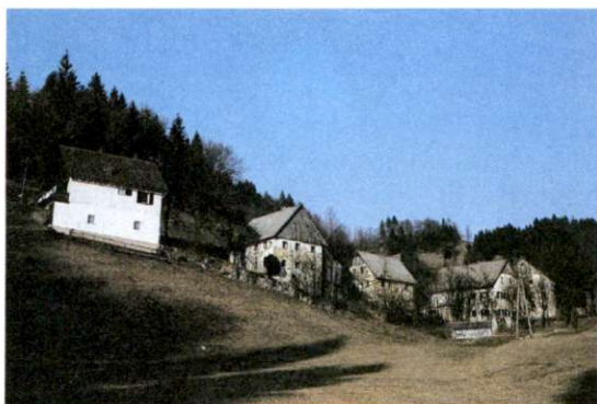
Slika 2: Potres leta 1976 je močno prizadel naselja na planoti. S popotresno obnovo se je spremenila podoba vseh vasi, saj je bila večina poslopij obnovljena, kar nekaj starih kmečkih hiš pa so zamenjale montažne stavbe. Podobno kot drugod v Posočju je v tem času nastala velika škoda v kulturnovarstvenem pogledu. (Foto: K. Kofol.)
