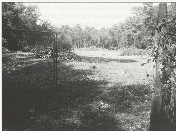
Priprava prostora za bodoči center
