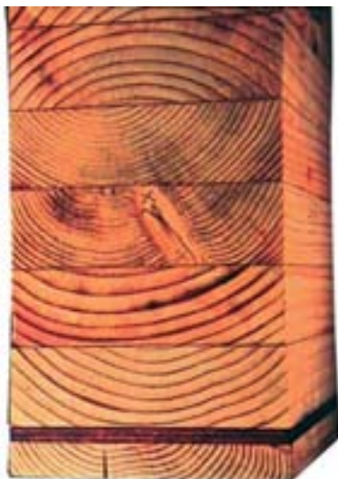
Slika 1: Ojačitev natezne cone z lamelami iz steklenih vlaken (FRP). Strengthening the bending zone with glass fibre lamellas (FRP).
