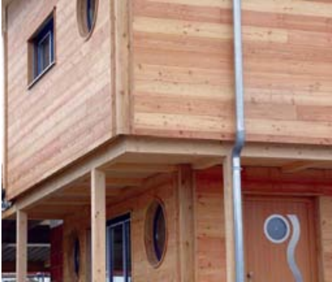
Slika 3: Obloga iz površinsko neobdelanega macesnovega lesa. (Vir: Riko-hiše) Cladding of larch timber with untreated surface.
