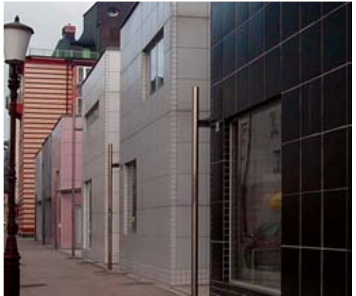
Slika 6: Obloga iz keramičnih plošč. (Foto: Martina Zbašnik-Senegačnik) Ceramic plate cladding.
