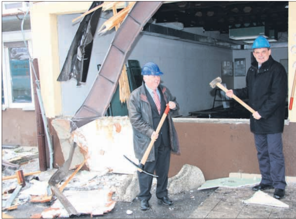
Uradno sta s podiranjem stare griške šole začela ravnatelj Franci Žagar in žalski župan Lojze Posedel.
