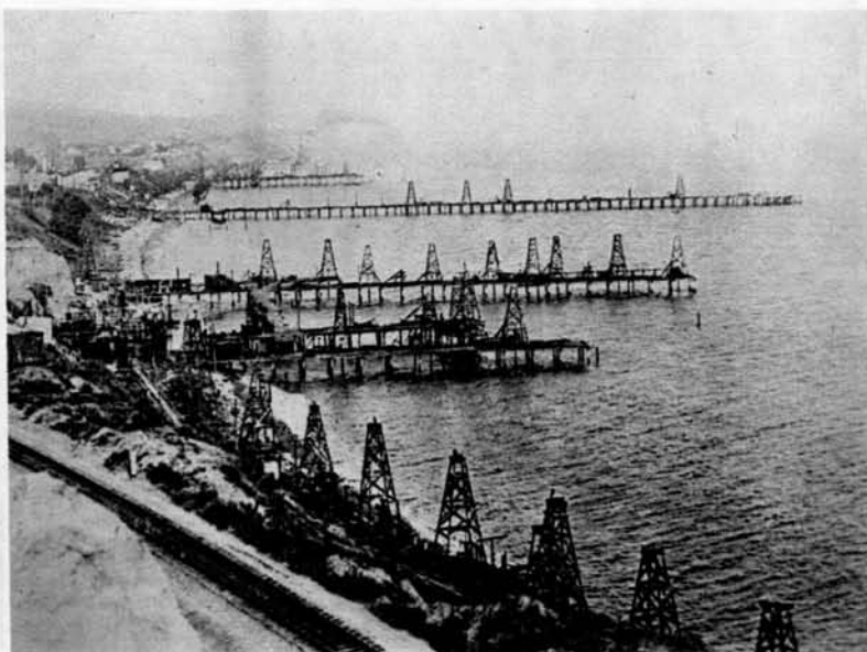
Najzanimivejša petrolejska polja na svetu se nabajajo v Kaliforniji. Polja leže pod morjem in posebne sesalke črpajo petrolej izpod vode.
