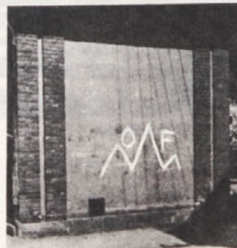
Znak OF na transformatorski postaji v Trnovem (15. maja 1942). Okupator je kmalu spoznal: OF je „država v državi“.
