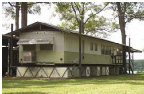
Slika 4 • Obstoječi hiši v južni Louisiani so dodani plovni temelj in vodila (levo); desno je razvidno, da je amfibijska hiša prestala poplavo nepoškodovana v primerjavi s poplavljeno hišo, grajeno na terenu ((English, 2009), (English, 2015))
