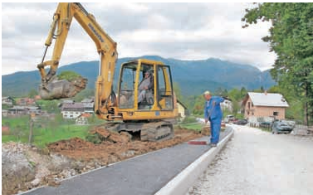
Na območju Tunjic, kjer je bilo težav tudi zaradi oviranja prometa največ, je bilo do sedaj zgrajenih šest kilometrov kanalizacije. / FOTO: GORAZD KAVČIČ
