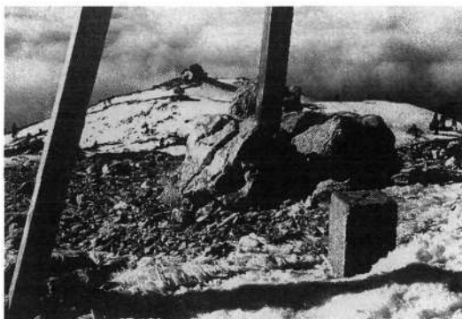
Triangulacijska točka na Krvavcu, fotografirana 11. februarja 1949: navadno je na glavi granitnega kvadra, ki je običajno zabetoniran v zemljinu
