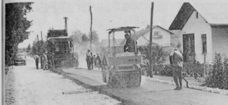
Asfaltiranje ceste Hajdina—Kidričevo
