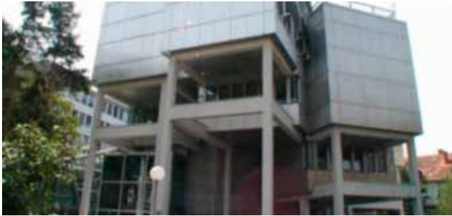
Foto 1: Stavba z nameščenimi sendvič fasadnimi paneli
