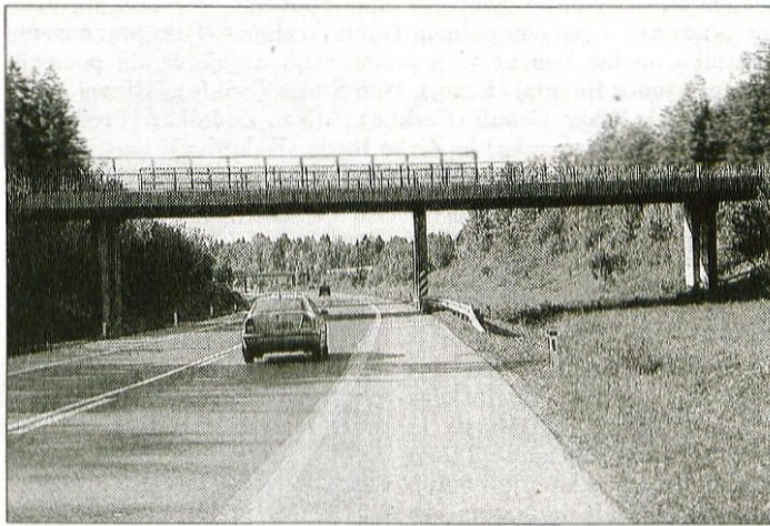
Že pred sedemnajstimi leti so bila opravljena glavna dela tudi za izgradnjo bodočega drugega dela štiripasovne avtoceste.
