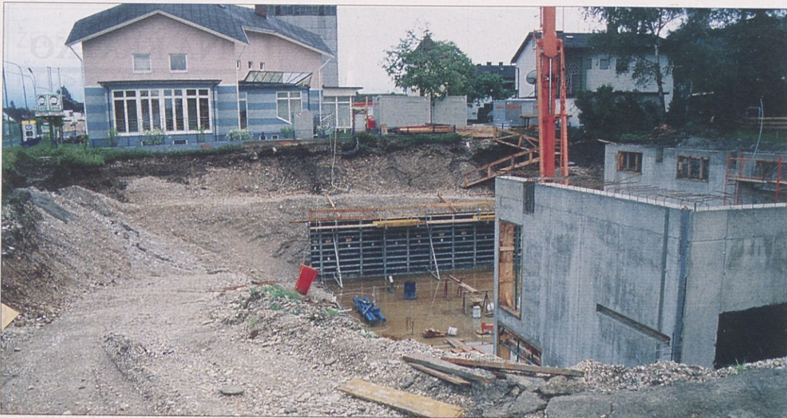
Kulturni dom v Pliberku je v občini eden največjih gradbenih projektov zadnjih desetletij in bo nudil v kleti tudi prostor za športno dvorano. Gradnjo je prevzelo domače gradbeno podjetje, ki trenutno betonira klet.
