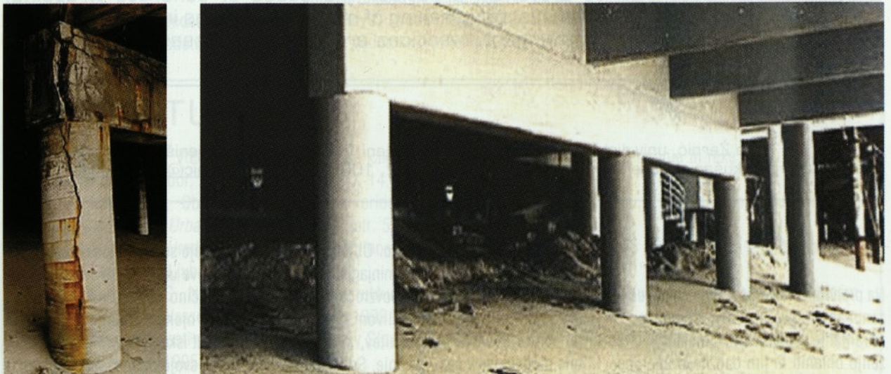
Slika 1: Primer popravila in protipotresne utrditve poškodovane armiranobetonske podporne konstrukcije mostu z ovojem iz epoksidne matrice, armirane s steklenimi vlakni (TYFO® Sytem, Composite Retrofit Intl., Montreal, Kanada)
