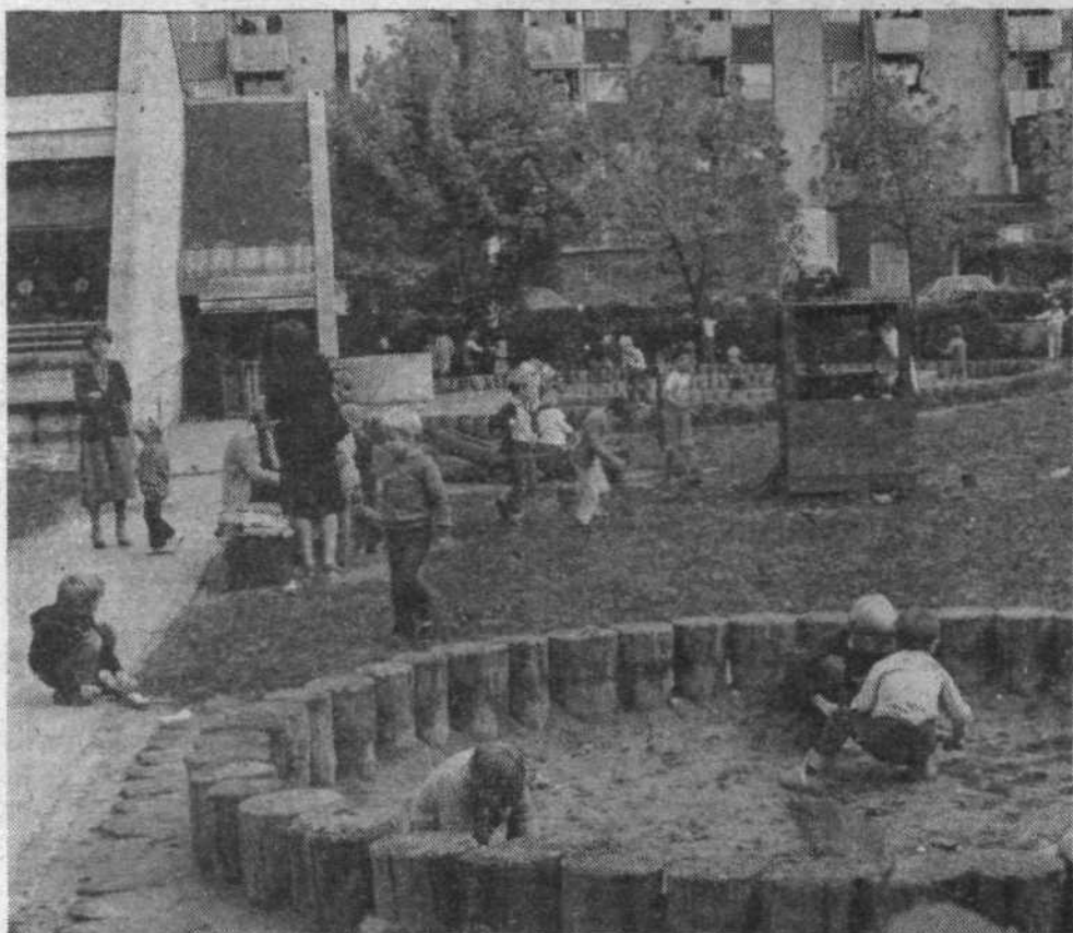
Vzgojno varstveni zavod Ciciban v Gogalovi ulici.
