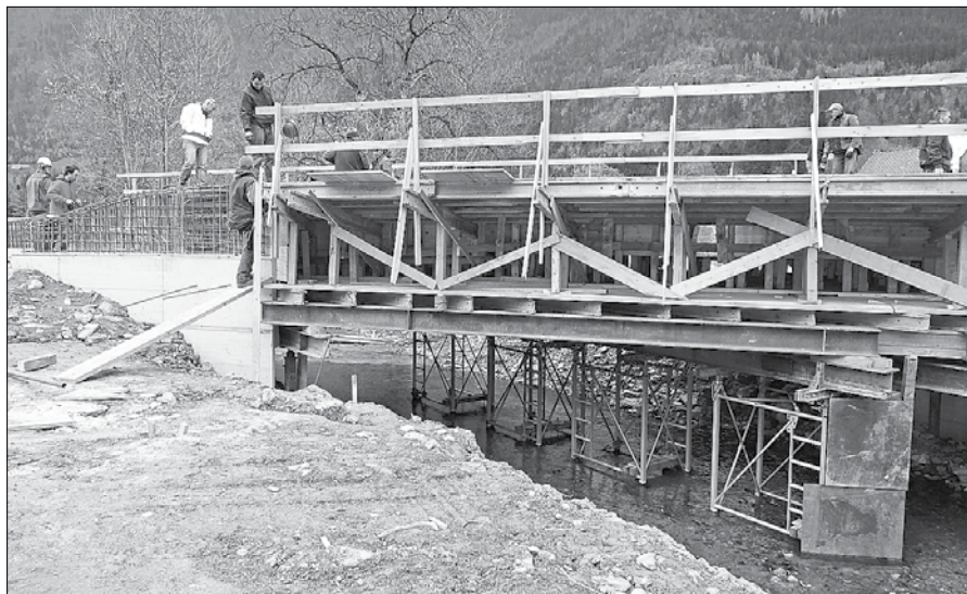
Gradnja mostu v Šmiklavžu poteka po planu, tudi po zaslugi vremena. (Foto: Stanko Ogradi)
