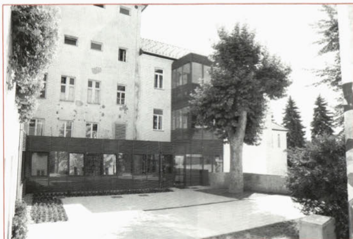
Pogled na novogradnjo z dvorišča kjer je povezovalni hodnik med starim in novim poslopijem.
