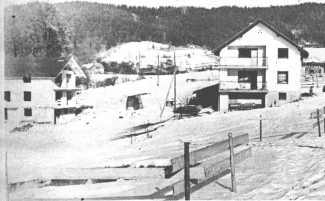
Po urbanističnem redu bodo v kraju zgradili nekaj novih stanovanjskih hiš.
