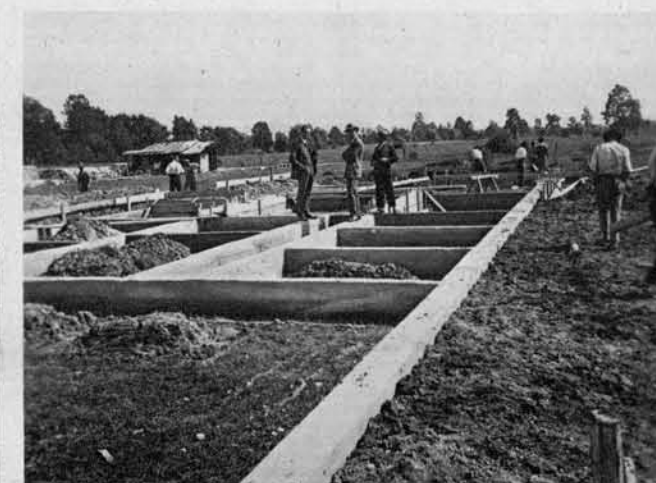
Temelji za novo, moderno radio-oddajno postajo pri Domžalah
